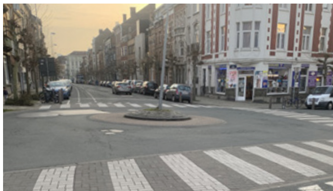
Figuur 3: Half overrijdbare rotonde (Schaarbeek)
