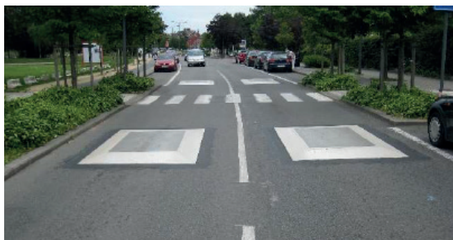
Figuur 1: Rijbaankussens (Stroobantsstraat, Evere)
