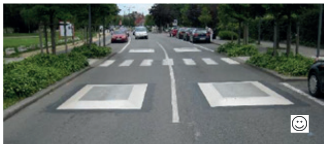
Figuur 7: Naast elkaar geplaatste rijbaankussens bij een zebraapad op een rijbaan die tussen 6 m en 7,2 m breed is [OCW 2020_1]
