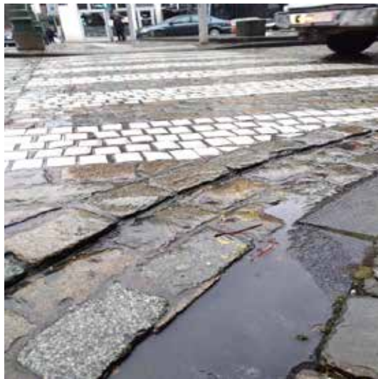
Figuur 7-13. Voor fietsers oncomfortabele en gevaarlijke combinaties van wegverharding die onregelmatig, glad en in slechte staat is
