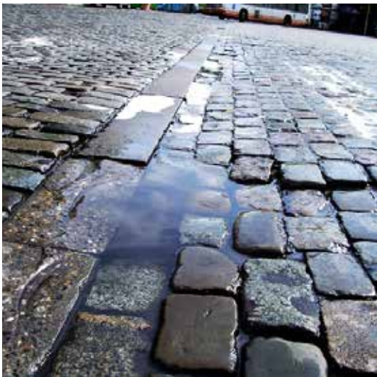
Figuur 7-13. Voor fietsers oncomfortabele en gevaarlijke combinaties van wegverharding die onregelmatig, glad en in slechte staat is
