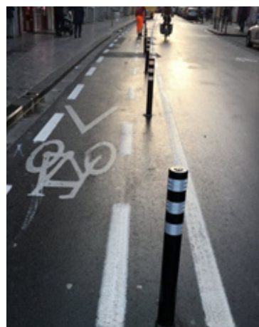
Figuur 2: Wegversmalling met markeringen en paaltjes
