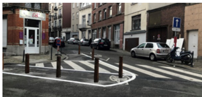
Figuur 1: Wegversmalling met markeringen en paaltjes
