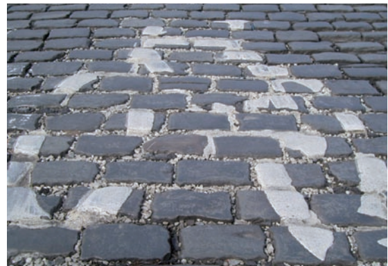
Logo vélo préformé endommagé sur des pavés en pierre
