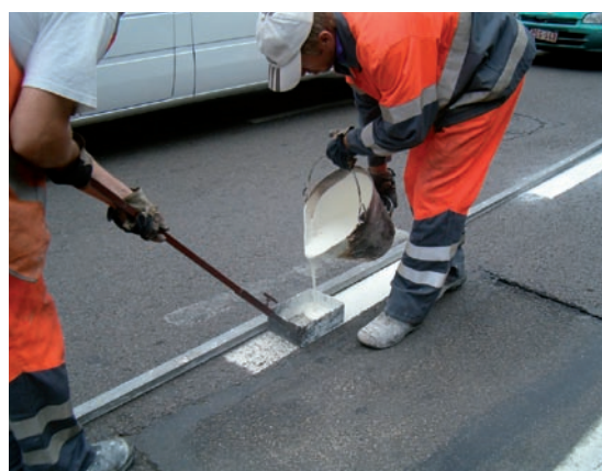
Marquage d'une piste cyclable par application à chaud d'un enduit thermoplastique
