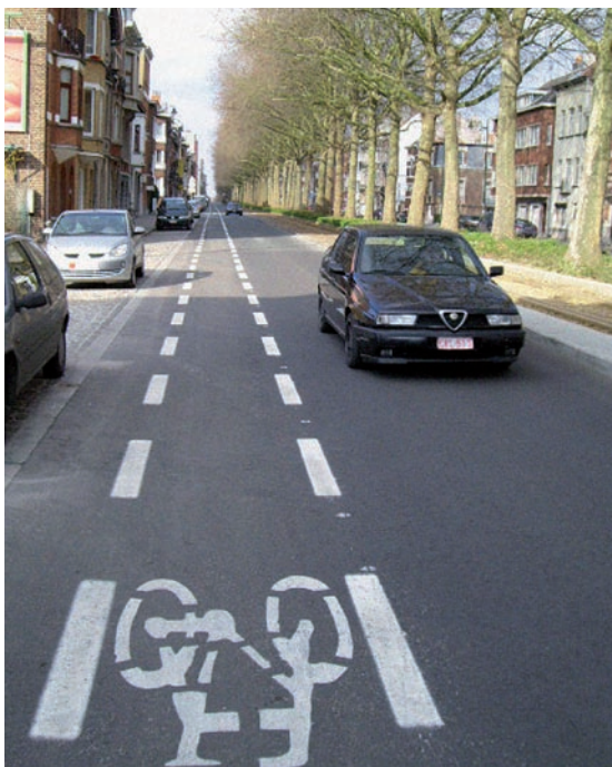
Premier marquage provisoirement en peinture
