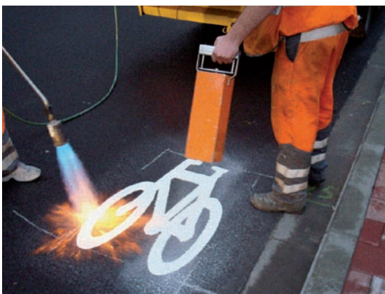
Pose d'un logo vélo au chalumeau et saupoudrage de billes réfléchissantes
