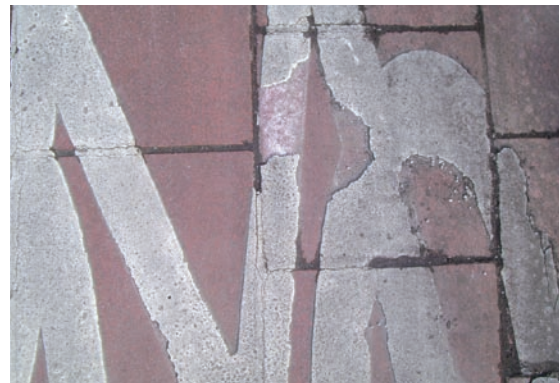
Usure d'un logo thermoplastique préformé sur un revêtement modulaire
