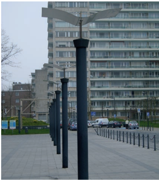
Éclairage bas en milieu urbain
