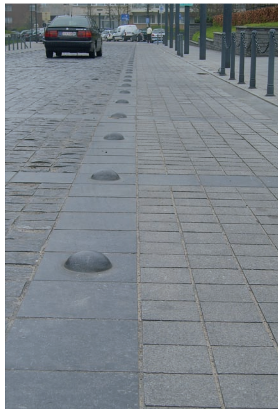
Plots en pierre à déconseiller en raison du risque de déstabilisation en cas de contact avec la roue avant du vélo
