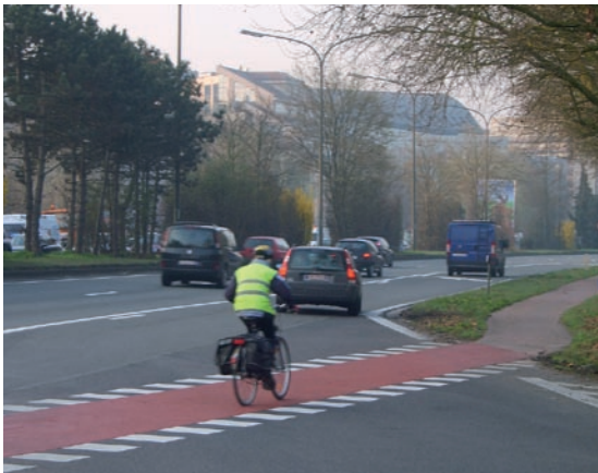
Traversée d'une voirie à grand trafic accentuée par un marquage rouge
