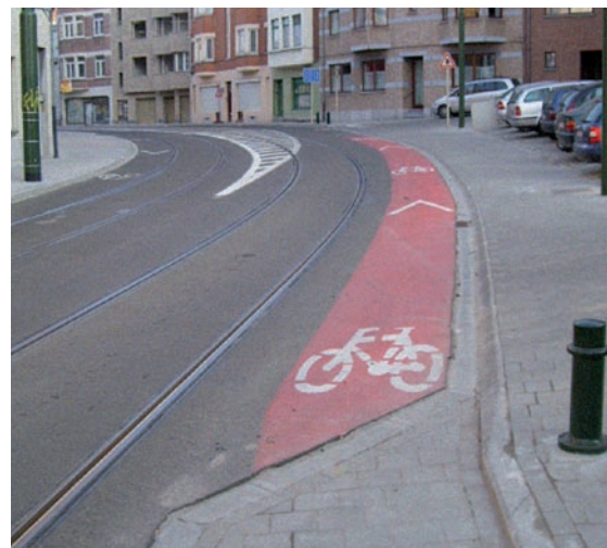
Aux zones d'insertion en voirie, la couleur rouge signale aux automobilistes que des cyclistes venant d'une piste cyclable séparée s'intègrent au trafic sur la voirie
