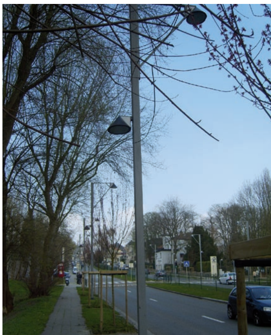
Éclairage double: un luminaire pour la chaussée et un autre pour les cyclistes
