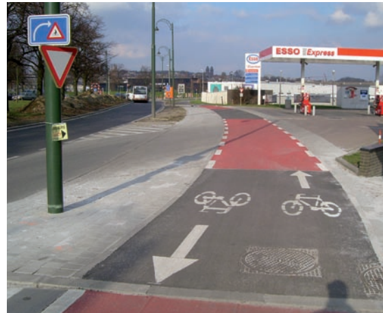
Le marquage peut être accentué de rouge lorsque la trajectoire du cycliste est coupée par une entrée ou un débouché latéral à forte fréquence (parking, pompe à essence, etc.)
