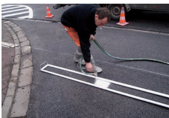
Marquage d'une piste cyclable par projection de peinture sur pochoir
