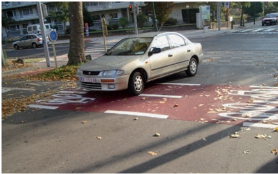
Traversée bi-directionnelle accentuée par un marquage antidérapant en bauxite rouge
