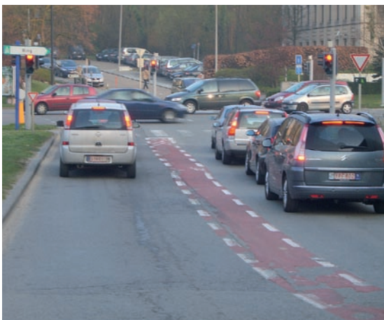
Zone de cisaillement en rouge, fortement sollicitée par le trafic automobile
