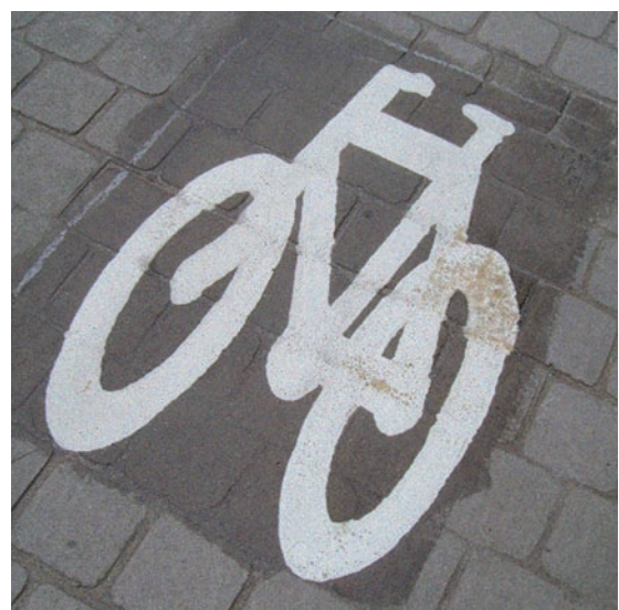
Logo vélo préformé appliqué à chaud sur du béton imprimé après application d'un «primer». Les joints du béton imprimé sont moins profonds, ce qui rend le marquage plus durable sur ce type de support
