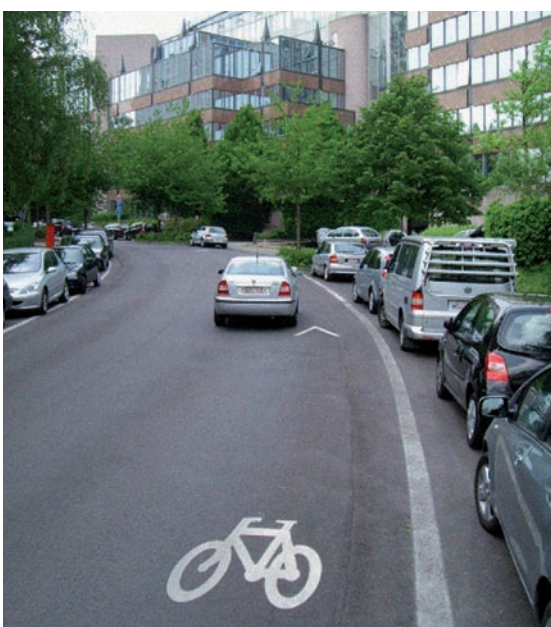
Bande cyclable suggérée. La trajectoire du cycliste sur la chaussée est accentuée par une succession de logos vélos et de chevrons
