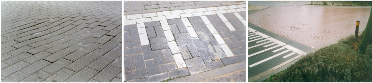
Afbeelding 80: Illustratie van de door de dynamische belasting veroorzaakte beschadigingen
