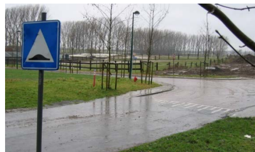
Afbeelding 82: Er moeten maatregelen worden getroffen om de problemen in verband met de doorsijpeling van afvloeiend water aan te pakken.
