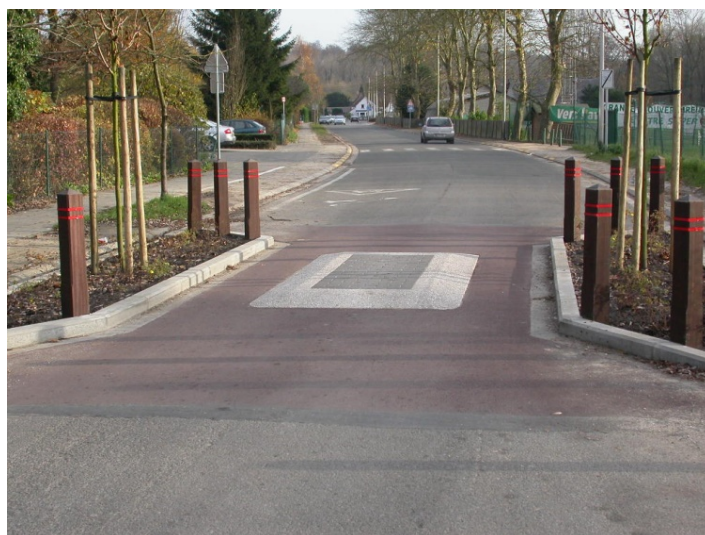
Afbeelding 64: Rijbaankussens waarbij een wegversmalling ontstaat: rijbaan < 5 m enkele richting (links), rijbaan < 6 m dubbele rijrichting (rechts)
