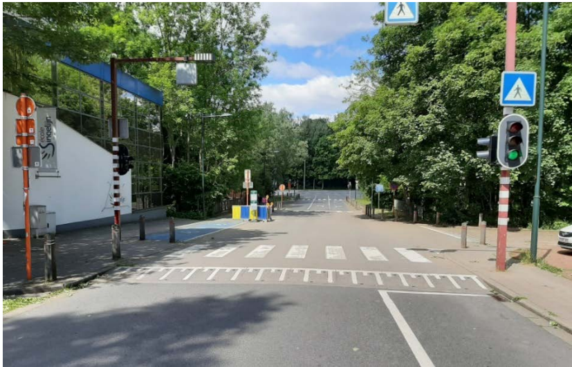
Afbeelding 35: Verkeersplateau in normaalprofiel met voetgangersverkeer in de omgeving van een school of aan het einde van een groene weg (Veldkapellaan - Sint-Lambrechts-Woluwe - Net Auto Plus)
