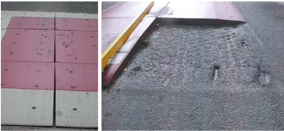
Afbeelding 108: Illustratie van de verplaatsing van onderdelen van rubberen rijbaankussens en schade aan de verharding
