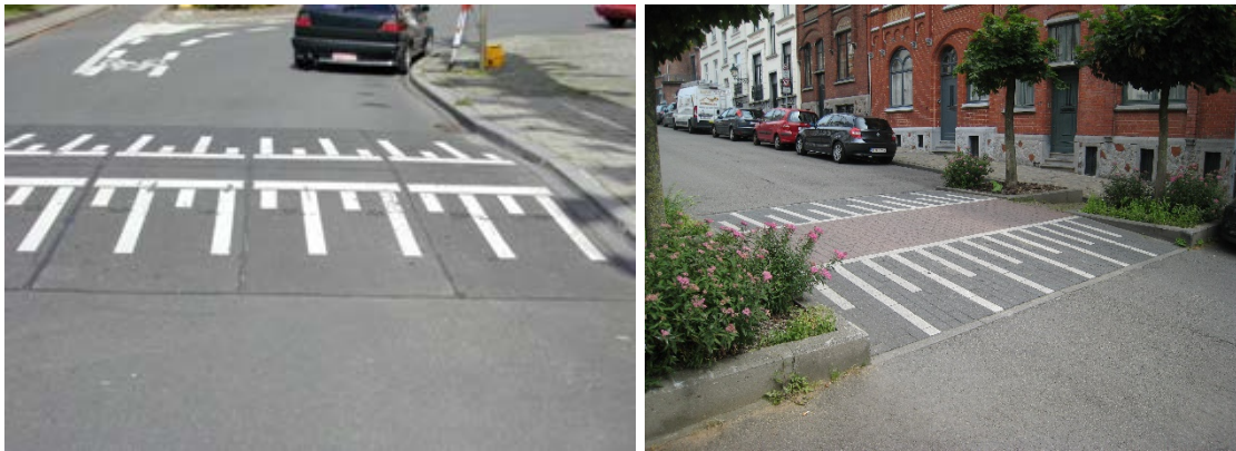
Afbeelding 5: Verkeersdrempel bestaande uit geprefabriceerde elementen (links) en straatstenen (rechts)
