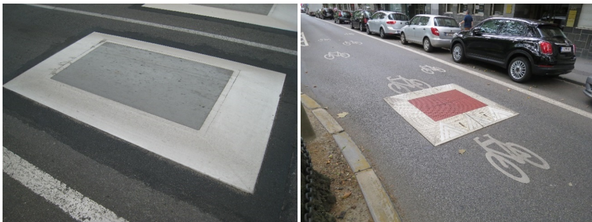
Afbeelding 104: Illustratie van twee types aanlegwijzen van rijbaankussens
