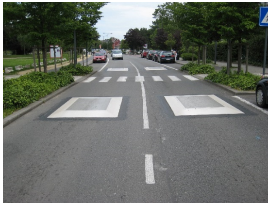
Afbeelding 70: Naast elkaar geplaatste rijbaankussens in de buurt van een voetgangersoversteekplaats op een rijweg van 6 tot 7,2 m breed
