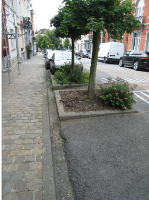
Afbeelding 54: Aanleg van latere verkeerseilanden voor het behoud van de waterafvoergoten ter hoogte van een verkeersdrempel
