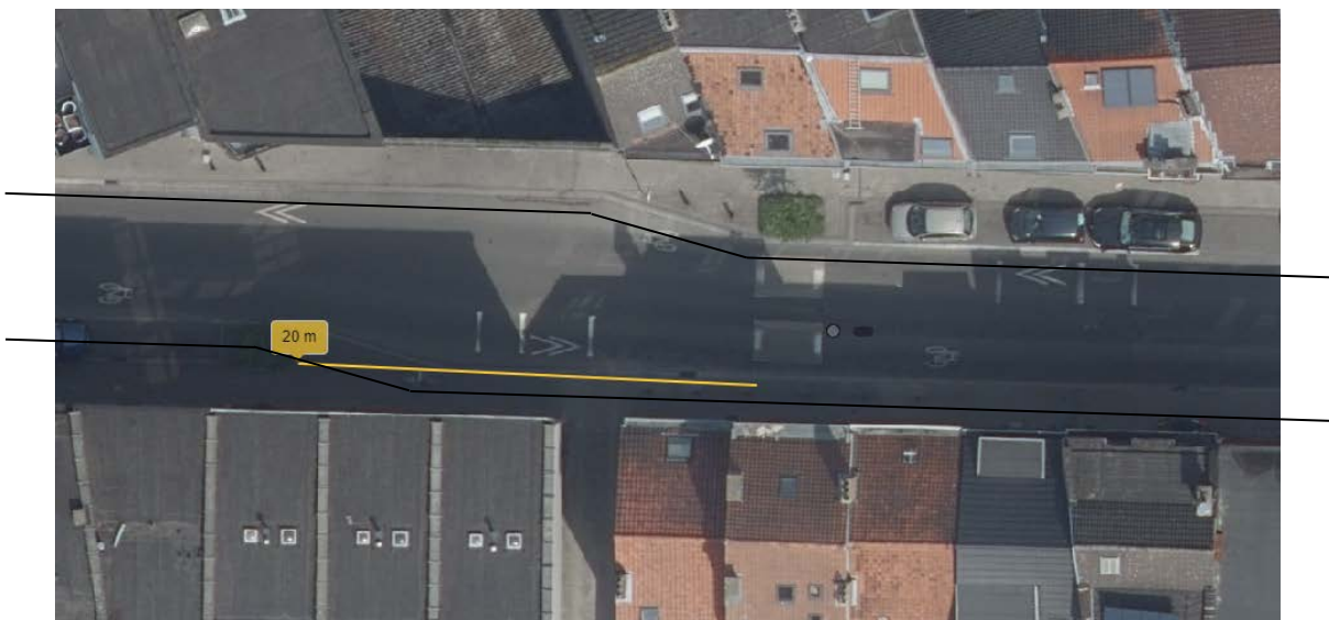
Afbeelding 62: Te korte afstand tussen de rijbaankussens en de zigzagdoorgang, waardoor een goede uitlijning van de bussen ten opzichte van de overlangse aslijn van de kussens niet mogelijk was (Joseph Wautersstraat in Schaarbeek) en ze dus werden verwijderd
