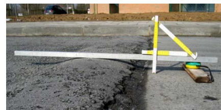
Afbeelding 88: Illustratie van het mogelijke effect van de thermische uitzetting van een betonnen verharding op een bitumineuze verharding of een bestrating
