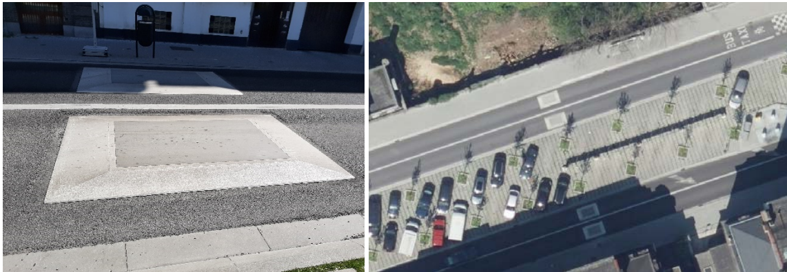
Afbeelding 67: Twee naast elkaar geplaatste rijbaankussens op een tweebaansweg in dezelfde richting (Vrijheidslaan - Koekelberg)
