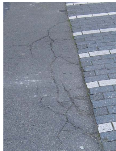
Afbeelding 89: Noodzaak om maatregelen te treffen om de insijpeling van afvloeiend water in een bestrating aan te pakken
