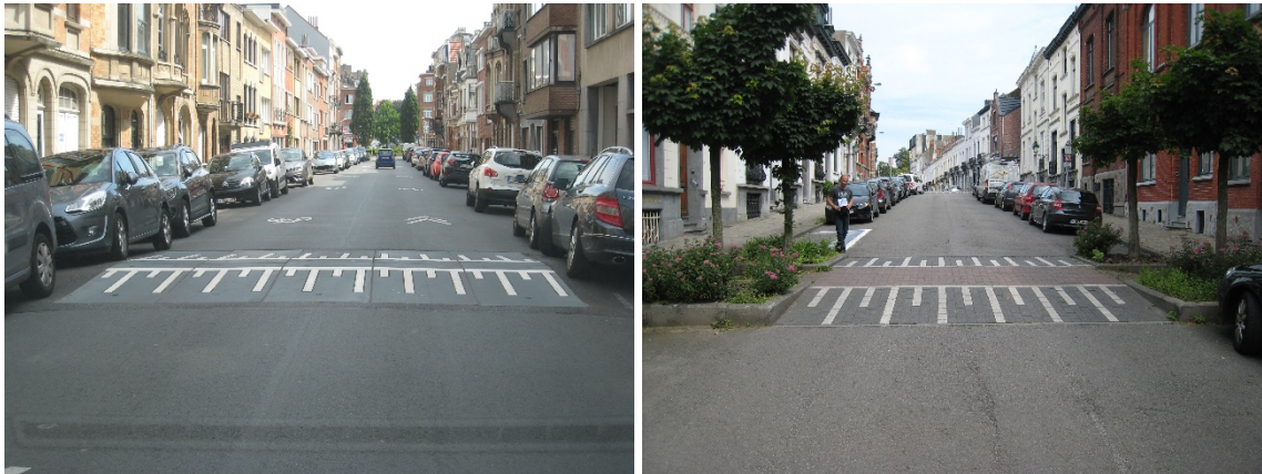
Afbeelding 17: Installatie van een verkeersdrempel met of zonder bijkomende inrichting
