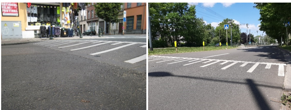
Afbeelding 4: Vorm van de op- en afritten van een (sinusoidaal of vlak) verkeersplateau
