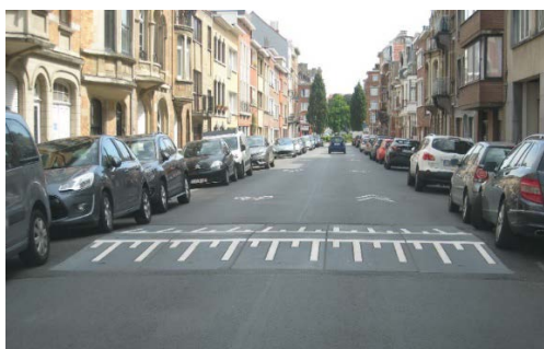
Afbeelding 57: Kammarkering op de op- en afritten (de witte langsstrepen hebben een breedte van ongeveer 0,10 m; de lange strepen hebben een lengte van ongeveer 1,00 m; de korte strepen hebben een lengte van ongeveer 0,40 m; de tussenafstand tussen twee strepen bedraagt ongeveer 0,20 m; de witte dwarsstreep heeft een breedte van ongeveer 0,20 m).
