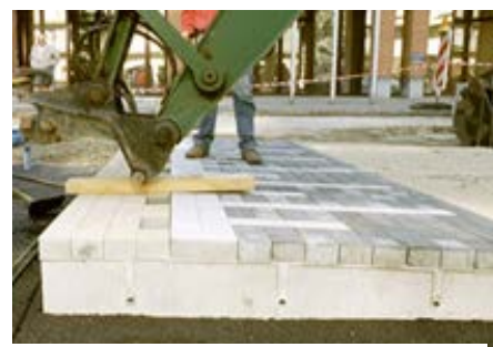
Afbeelding 77: Geprefabriceerde elementen met een bestrating in steen
