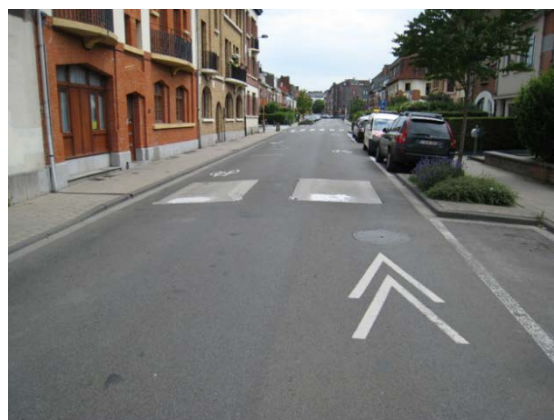
Afbeelding 25: Inrichting van de berm om het parkeren ter hoogte van de rijbaankussens te vermijden (bijvoorbeeld van een rijbaan van 6,20 m breed, nb. halverwege tussen de twee rijbaankussens ontbreekt er een witte doorlopende lijn)
