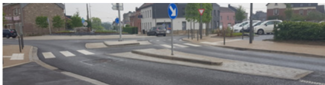
Figuur 1: Middeneiland dat als vluchtheuvel kan worden gebruikt door voetgangers (de markering van de oversteekplaats kan worden verlengd op het overrijdbare deel van het middeneiland)
