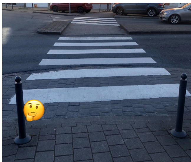
Figuur 3: Middeneiland met oversteekplaats voor voetgangers (Schaarbeek). De toegankelijkheid van de oversteekplaats, zoals niveau 0 en straatstenen, ontbreekt echter nog.
