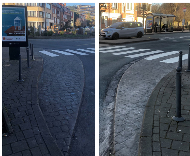
Figuur 5: Overrijdbaar verkeerseiland (Schaarbeek)
