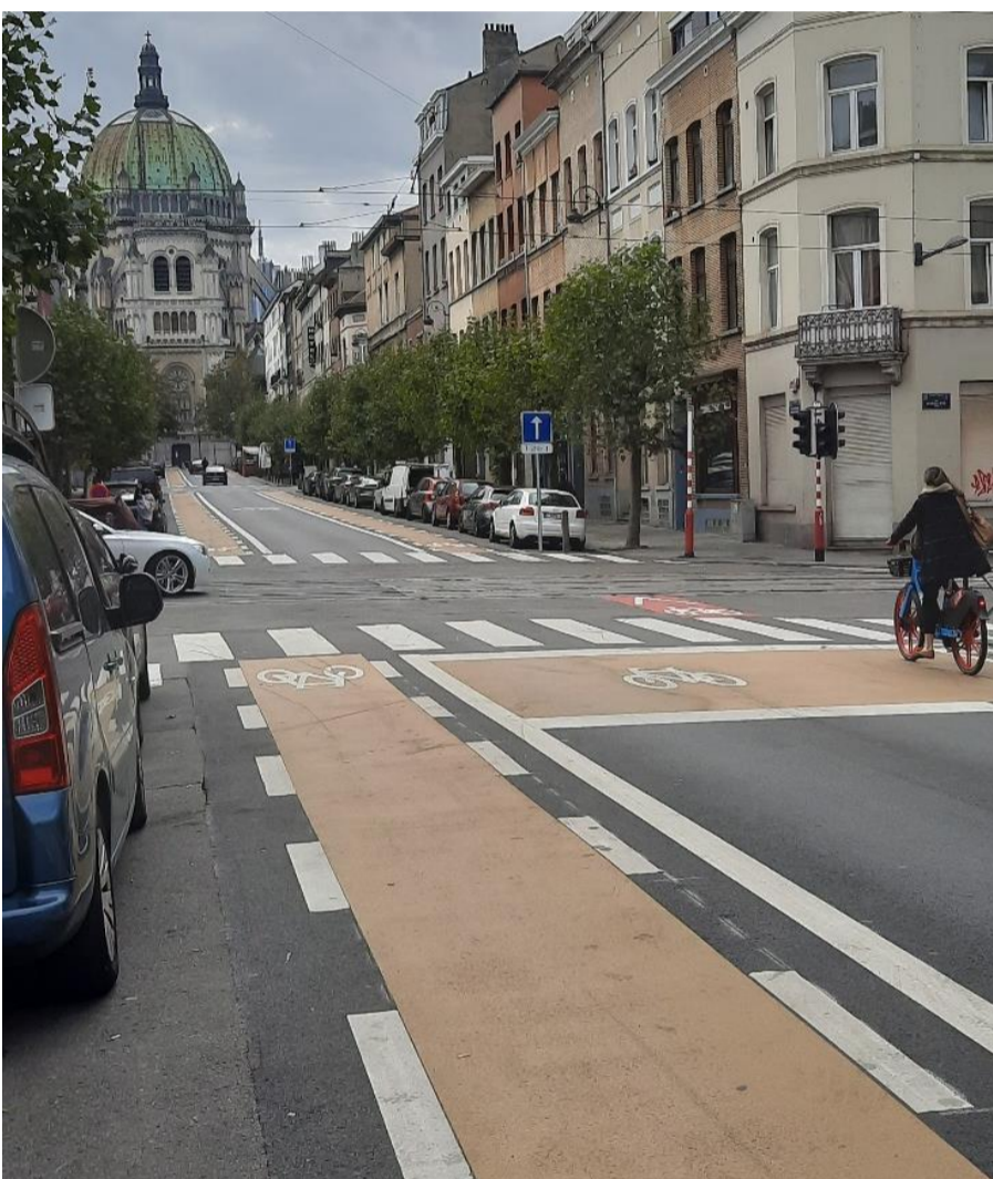
Koninklijke Sinte-Mariastraat (Schaarbeek): door in de straat eenrichtingsverkeer in te voeren, werd er ruimte vrijgemaakt om comfortabele fietspaden aan te leggen.
