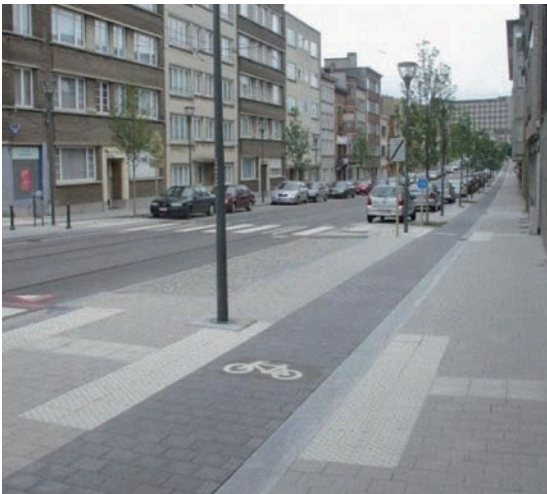
Rue sans différence de niveau pour les marcheurs, les cyclistes et les traversées [Tom Dhollander].
