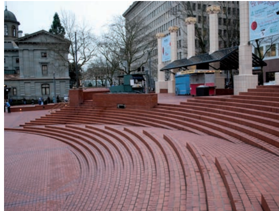
Pas d'escalier à part pour les personnes à mobilité réduite [Portland – Cory Silva].
