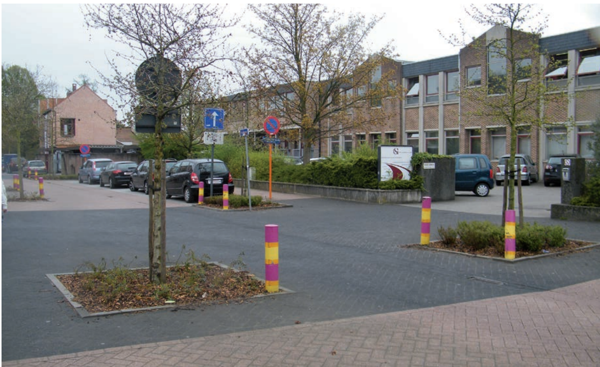
Entrée d'école sécurisée – rétrécissement, espace partagé, à niveau [Boechout].
