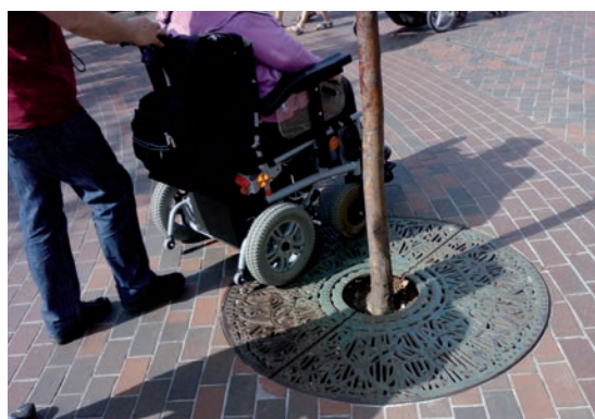
Couverture à plat des racines des arbres [Mortsel].
