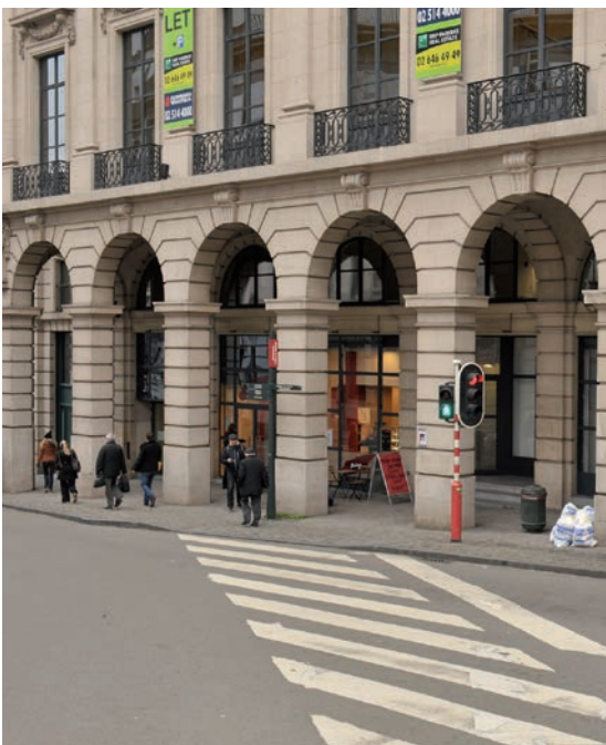
Beschutting door arcades.
