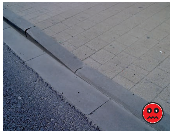
Hellende trottoirs bij auto-inritten zijn een obstakel en niet-reglementair.
