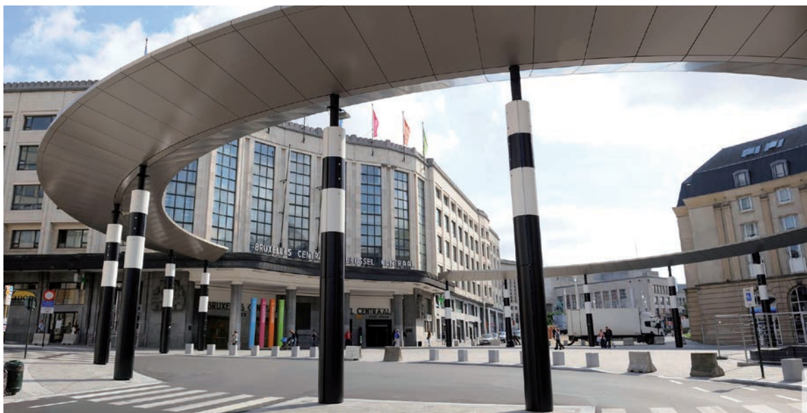
Hoofdingang van het Centraal Station.
