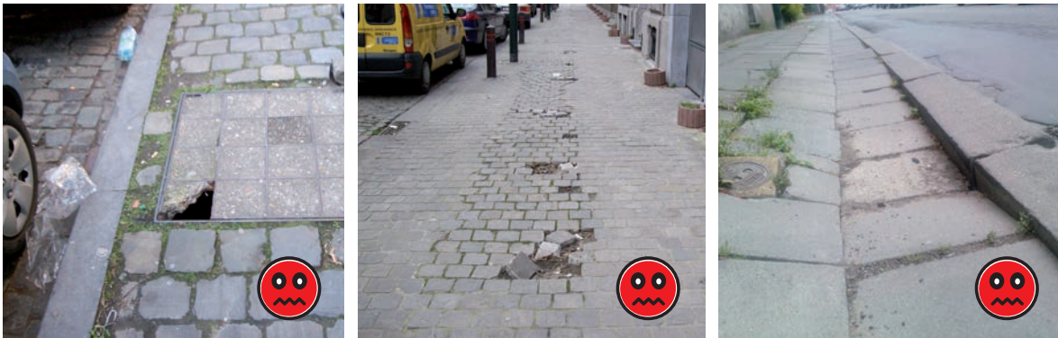
Te voorkomen: beschadigde trottoirs (verzakingen, slechte herstelling na werken).
