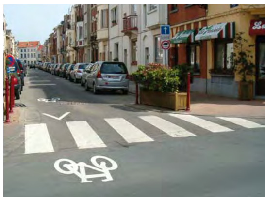
Figure 2.1. – Ce marquage de logos vélos et chevron est clairement visible pour les piétons s'apprêtant à traverser et pour les conducteurs qui doivent s'engager dans le sens unique limité ou céder la priorité aux cyclistes venant de leur droite.
