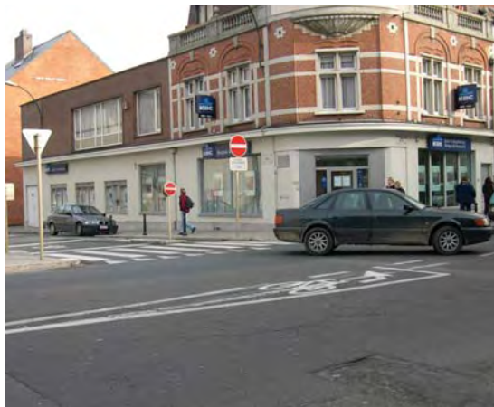
Figure 5.4. – Tourne-à-gauche facilitant l'accès du cycliste au contresens (voir aussi la figure 9.1. fiche n° 9).
