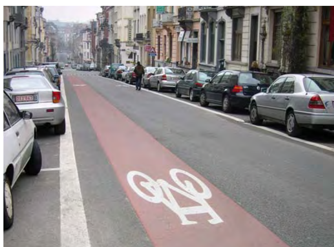
Figure 8.12. – BCS avec logo sur fond rouge à contresens et BCS simple «dans le sens».
