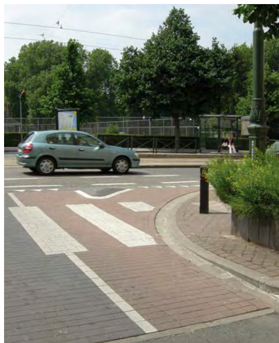
Figure 4.5. – Sortie de contresens cyclable sur une voirie prioritaire: aménagement intéressant mais moins compréhensible pour les automobilistes en raison de l'absence de logo vélo.
