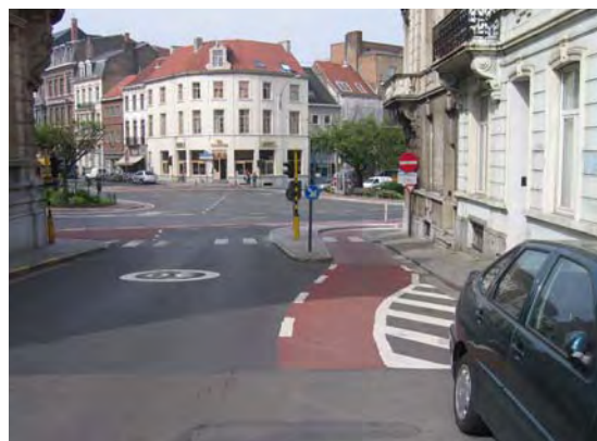
Figure 9.3. – Dans ce carrefour en sortie de contresens cyclable, les cyclistes ne peuvent ni continuer tout droit ni tourner à gauche. Un îlot les oriente donc vers la droite.
