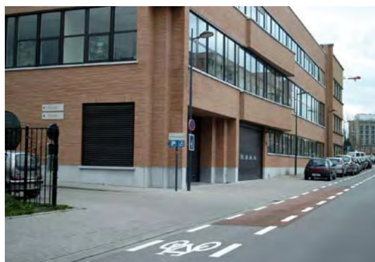
Figure 6.2. – PCM à contresens avec « surlignage » en schlamm rouge devant une sortie de garage.
