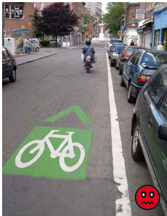
Figure 1.2. – Répétition de simples chevrons (ici dans une rue à double sens). L'utilisation de la couleur verte, peu visible (encore moins par temps de pluie) est à proscrire. Les chevrons (et les logos) doivent être réalisés en blanc.
