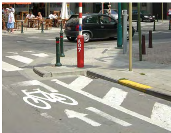
Figure 7.3. – Contresens cyclable aboutissant sur un carrefour à feu: une ligne d'arrêt a été marquée pour les cyclistes.
