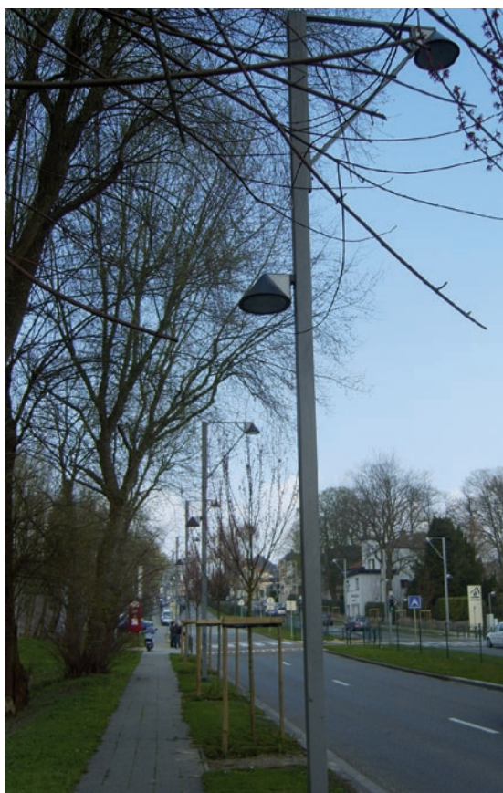
Verlichtingsmast met twee armaturen: een voor het fietspad en een voor de rijbaan
