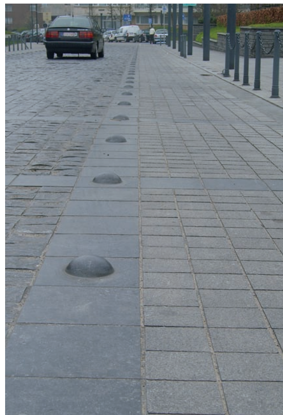
Bolvormig verkeersgeleidingselementen zijn af te raden wegens het verhoogde risico op valpartijen
