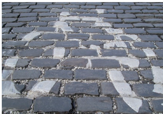
Beschadigd voorgevormd fietslogo op een straatkeiverharding
