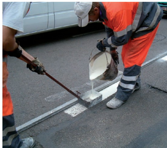
Markeren van een fietspad met thermoplasten
