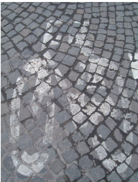
Afgesleten geverfd fietslogo op een elementenverharding
