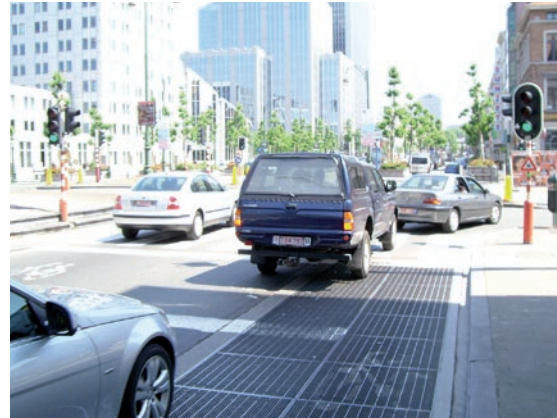
Onleesbare markering voor een fietsopstelstrook
