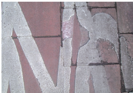
Afgesleten voorgevormd thermoplastisch fietslogo op een elementenverharding
