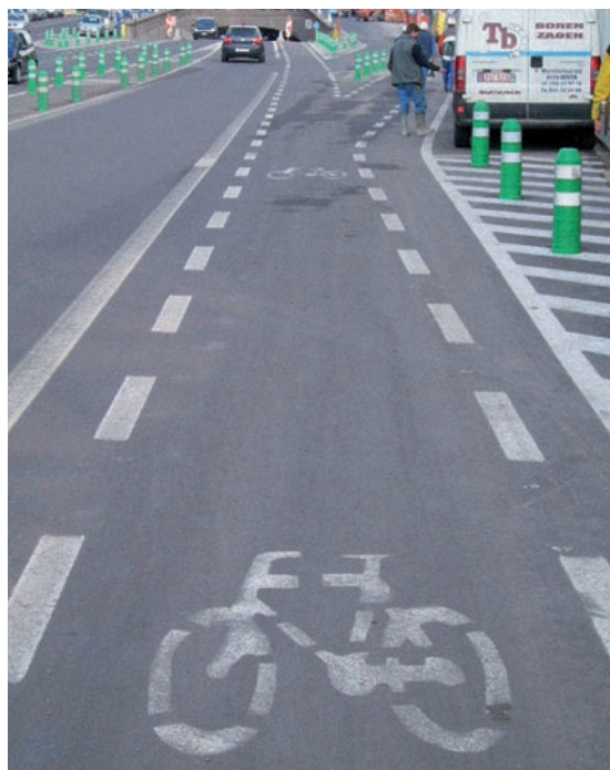
Voorlopige markering met wegverf
