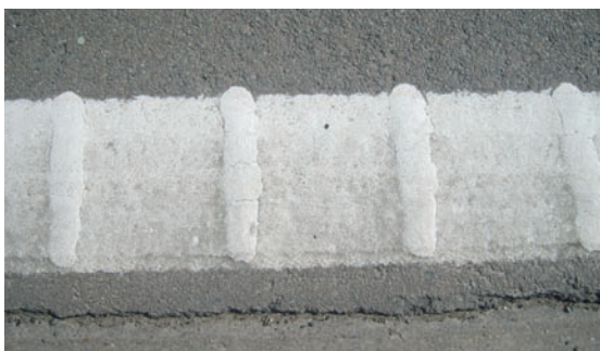
Akoestische ribbelmarkering voor automobilisten: grote opstaande blokken
