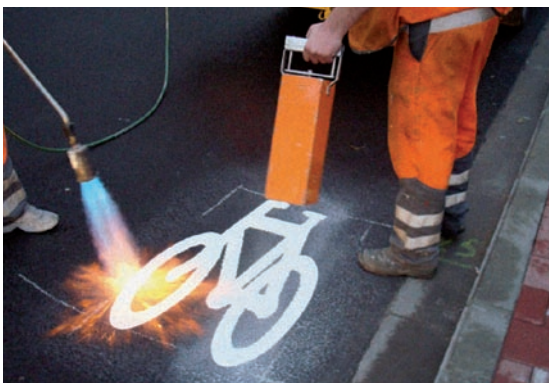
Aanbrenging van een voorgevormd fietslogo met gasbrander en afstrooien met glasparels met retroreflecterend effect
