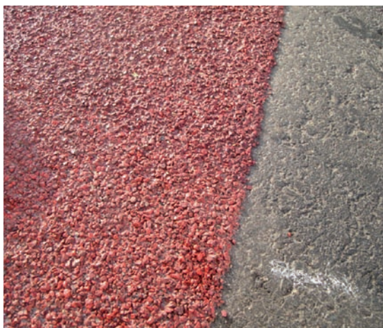
Wegmarkering met rood bauxiet voor een betere stroefheid
