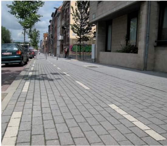
Wegmarkering van witte betonstraatstenen
