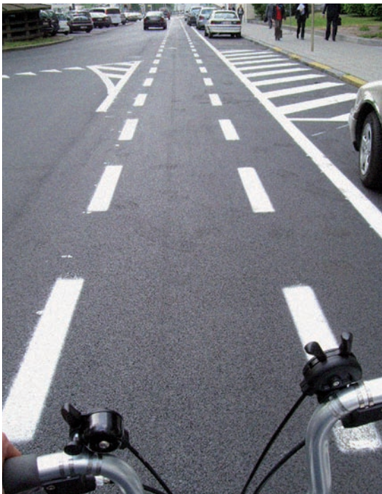
Gemarkeerd fietspad. Wegmarkeringen zorgen dat fietsers aan de kruising voorrang behouden
