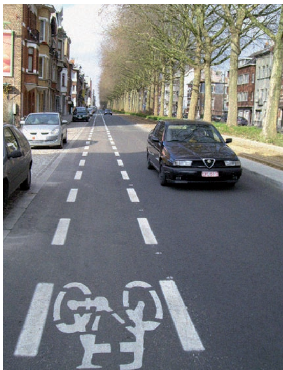
Voorlopige markering met wegverf
