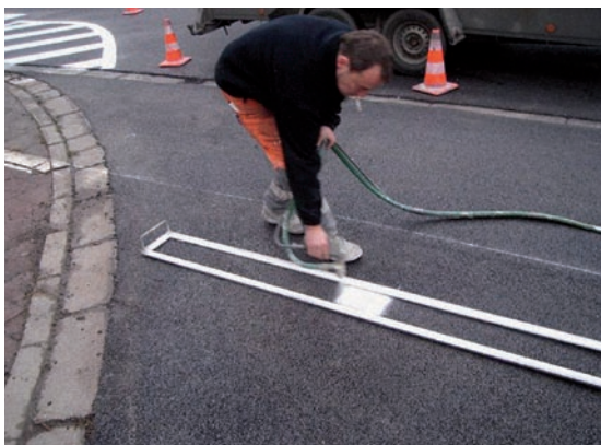
Markeren van een fietspad met wegeverf en sjablonen
