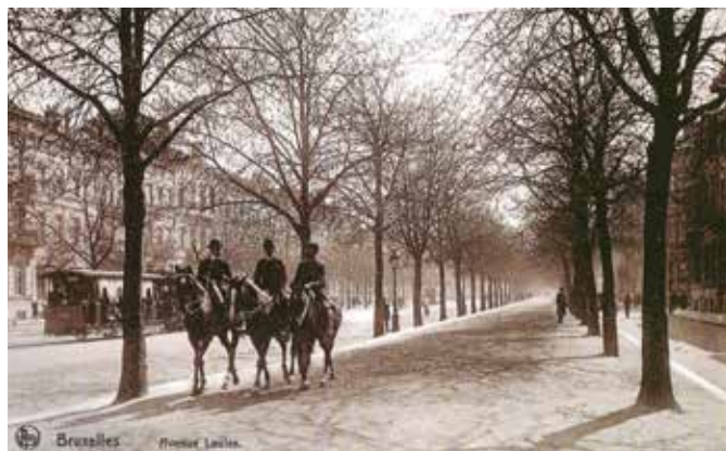
Figuur 7. Het eerste deel van de Louizalaan: 11 meter brede ventweg bedekt met steenslag voor ruiters, foto van omstreeks 1910
