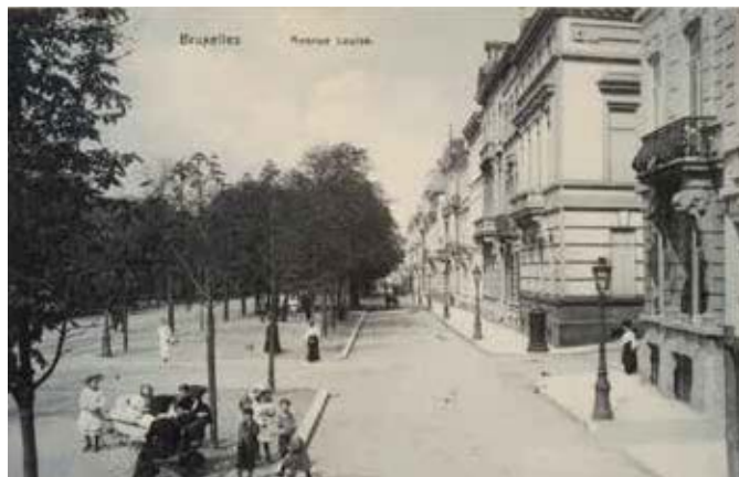
Figuur 8. Het eerste deel van de Louizalaan: 6 meter brede zijweg met kasseiverharding (één aan elke kant) voor plaatselijk verkeer en vrachtovertuigen, omzoomd door 3 meter brede voetpaden voor de bewoners, foto van omstreeks 1920
