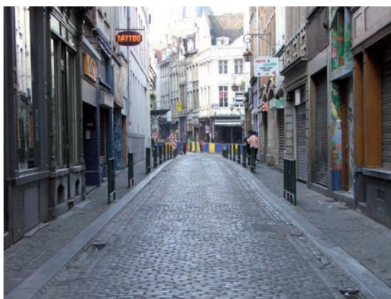
Voirie avec séparation en trottoir et chaussée et susceptible de devenir une zone de rencontre vu le contexte local et l'étroitesse des trottoirs.
