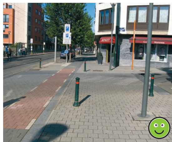
Trottoir traversant conforme (niveau constant et même coloration).
