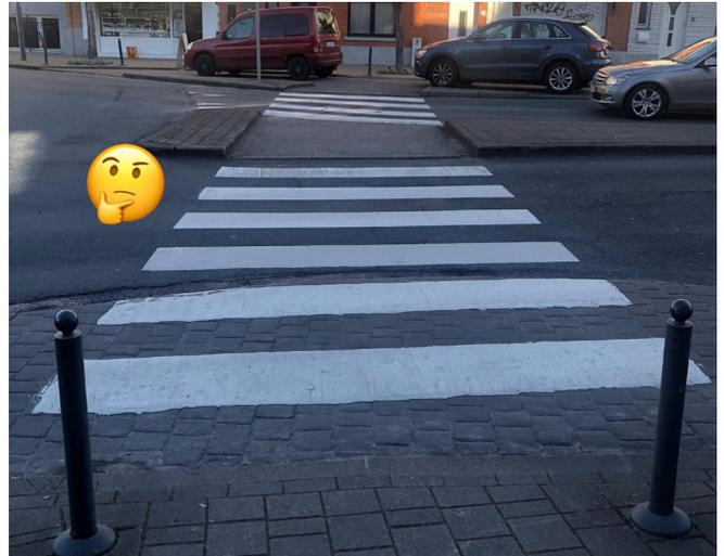
Figure 3 : Îlot central avec un passage pour piétons (Schaerbeek). Il manque cependant la mise en accessibilité de la traversée comme le niveau O et les dalles podotactiles.
