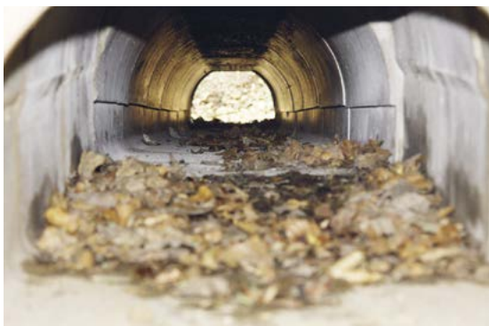
Figuur 72a – De tunnel is met lichtgaten voorzien en heeft een voldoende brede diameter om onderhoud te beperken in de tijd vanwege sedimentatie van stof en organisch materiaal uit de omgeving (bron: wegebouw.be).
