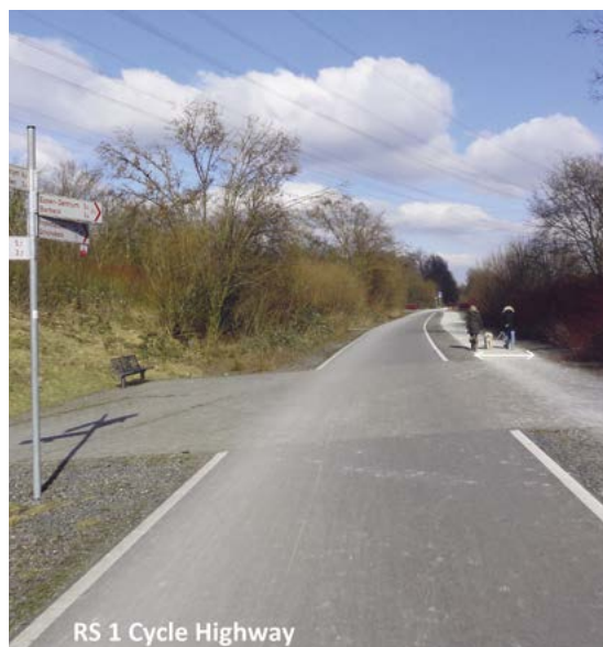
Figuur 19b – Voetgangers- en fietsgedeelte wordt door tussenberm en lijnmarkering van elkaar gescheiden – Voorbeeld uit Duitsland, RS1. © Joris Van Damme
