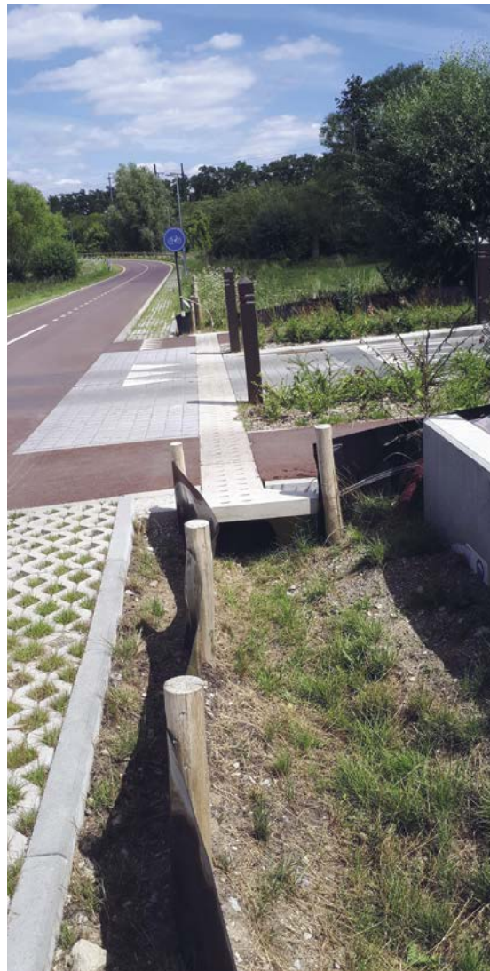
Figuur 72b – Voorbeelden van tunnels (voor amfibieën & ongewervelde dieren) onder de weginfrastructuur F1, Zemst (Vlaanderen). © OCW
