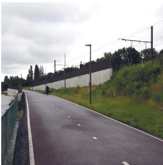
Figuur 33 – Kantopsluitingen (boordsteen) cyclostrades, Vlaanderen.
