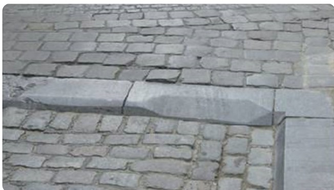
Bon chanfrein, mais mal positionné et pas suffisamment large. Les cyclistes/cyclomotoristes sont ainsi forcés à rouler dans la rigole.
