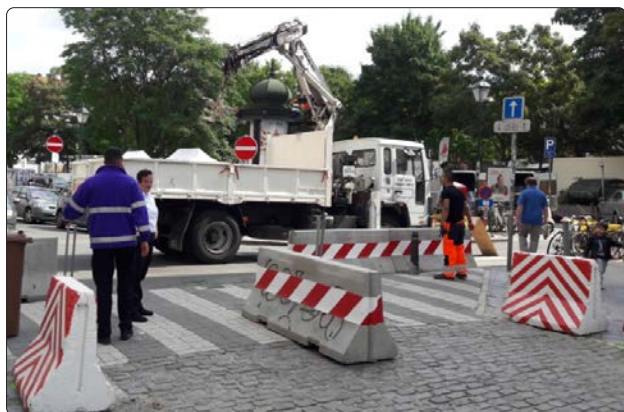
Placement initial des blocs de béton (photo de gauche) adapté en concertation avec le SIAMU sur le terrain (photo de droite) pour garantir l'accessibilité des véhicules d'intervention.
