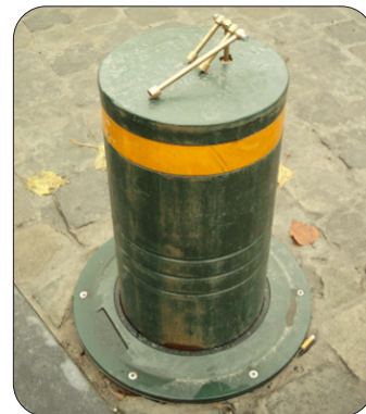
Automatische verdwinpaal die gedeblokkeerd kan worden met de nood sleutel.
