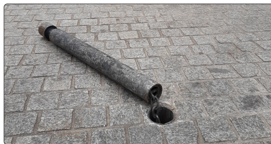
Afzonderlijk met een ketting aan de grond bevestigd paaltje.
